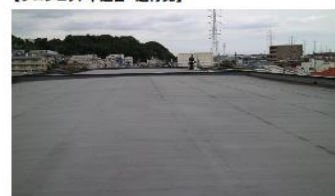
▲建設予定のアパート屋上
